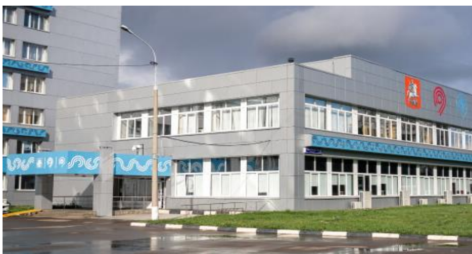
Рисунок № 2. Здание по адресу: ул. Криворожская, д.6, стр.1
