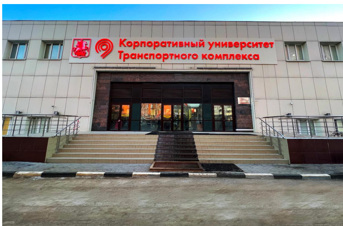
Рисунок № 1. Здание по адресу: Варшавское шоссе, 93
