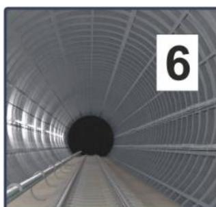
10. "4", "5", "6", "7", "8" - остановка первого вагона. Устанавливается в пределах пассажирской платформы на брус, а в тоннеле – на путевой стене (в тоннеле используется для остановки головного вагона при следовании сцепа объединенных поездов для высадки пассажиров на станции).
