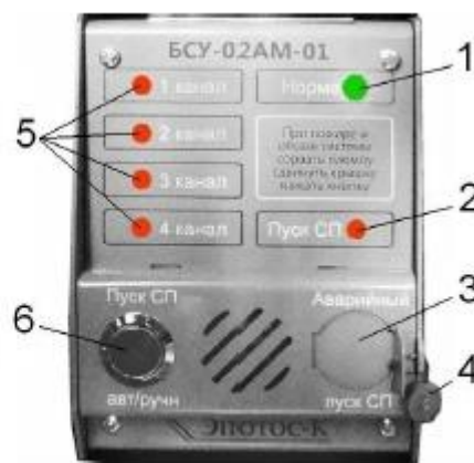
Рис. 23. Расположение пульта блока сигнализации и управления системы пожаротушения
