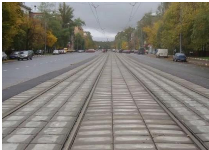
Рис. 5. Трамвайные пути, расположенные в проезжей части улицы
