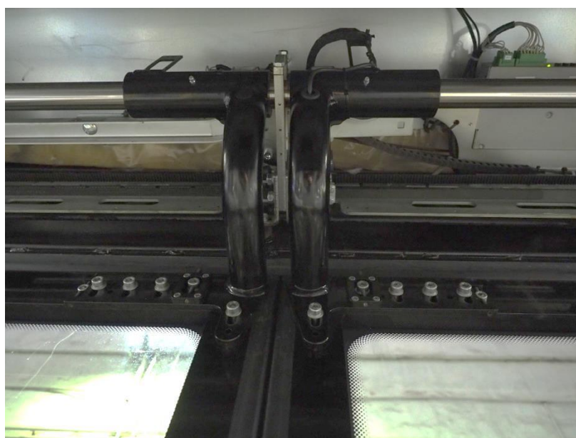
Рис. 31. Блоки передачи на направляющей оси
