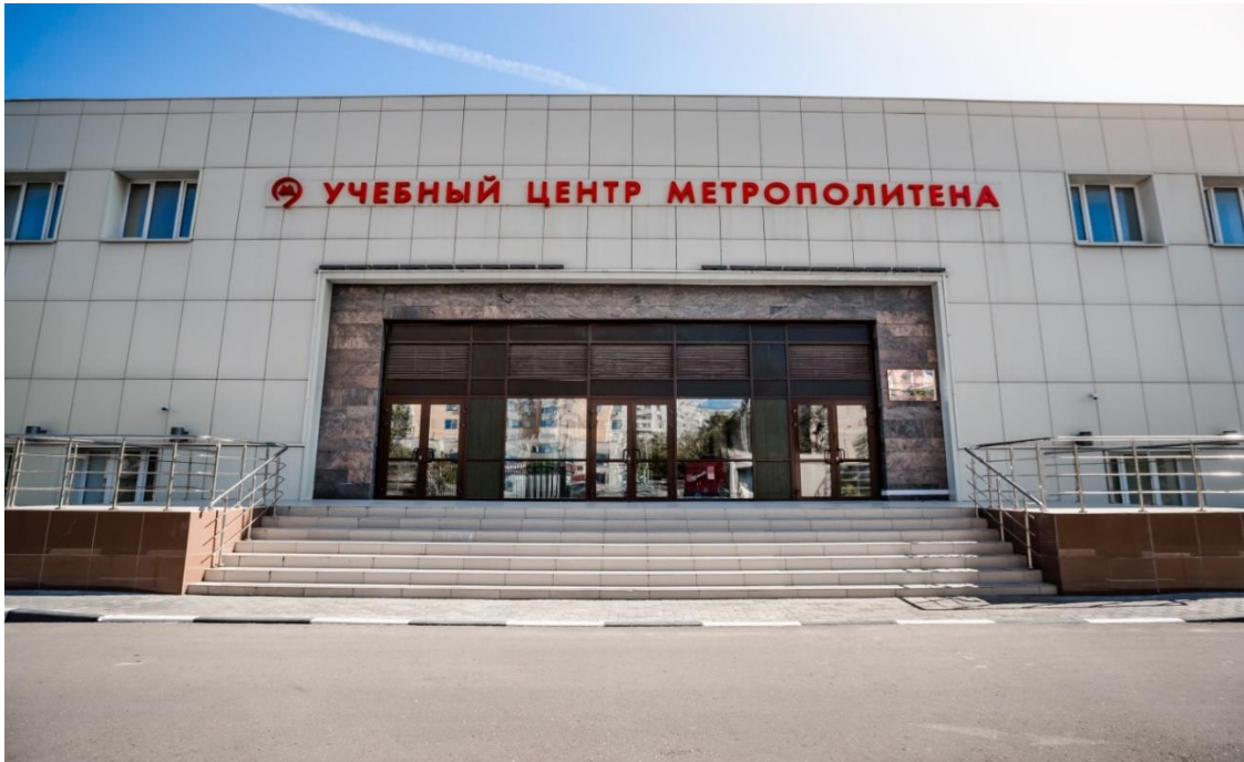
Рисунок № 1. Здание Учебно-производственного центра
